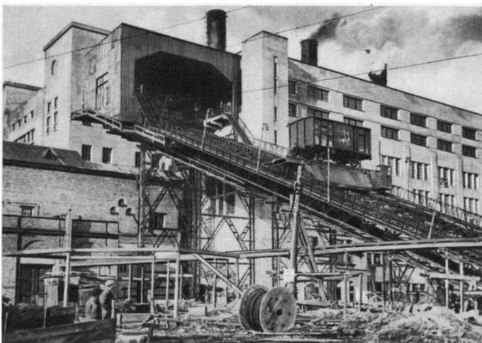
Las nuevas fábricas están equipadas con maquinaria automática para el combustible: los camiones son transportados a cierta altura y son vaciados
